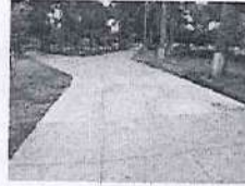
Reparación de vereda en Campo de Marte
