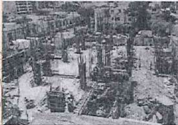
Encofrado de placas piso 1
