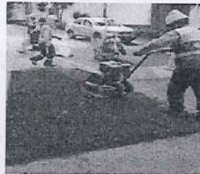
Resane de pavimento flexible en vías locales
