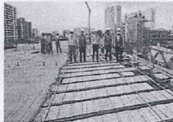
Vaciado de techo
