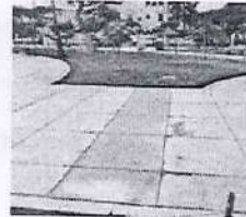
Reparación de vereda en parque Cáceres
