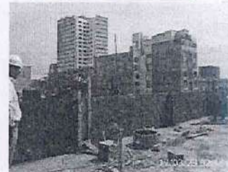
Tarrajeo de azotea
