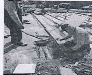
Trabajos de rehabilitación de pista en Horacio Urteaga
