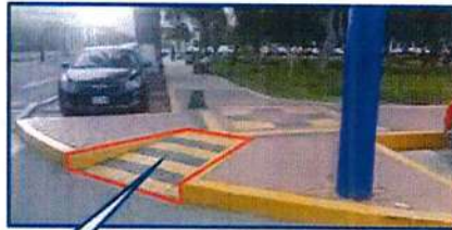
LAS RAMPAS DEL PARQUE TIENEN PENDIENTES MAYORES AL 12%, POR LO CUAL NO CUMPLEN CON EL REGLAMENTO
